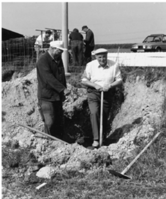
Bürgermeister Alois Reitmaier beim Spatenstich zur Stockschützenhalle im Jahr 1990. Kontrolliert wird des Ganze vom 1. Vorstand Wimmer Franz
